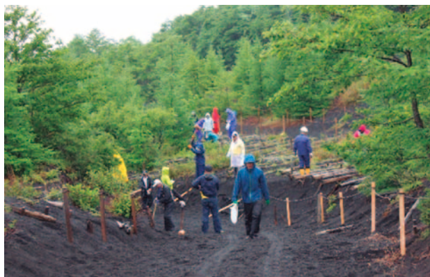
雨の中での作業風景②
