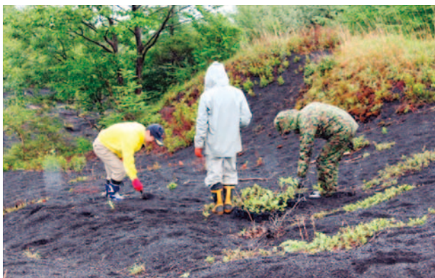
雨の中での作業風景①
