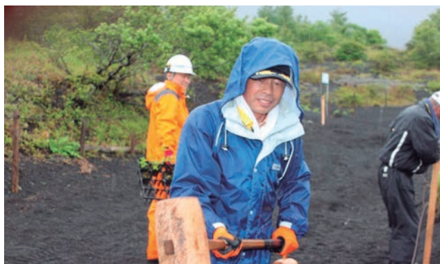
杭もしっかり打ち直します
